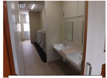
明るく清潔なトイレの完成
