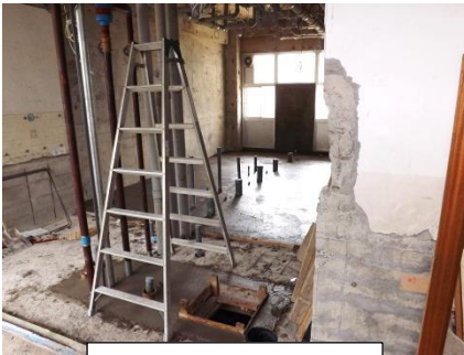
工事中のトイレ
